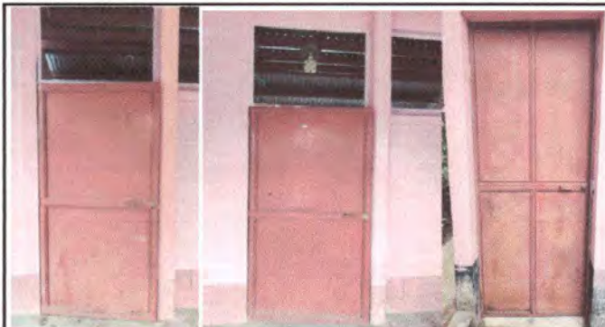
Foto 1: Sustrucción de puertas
