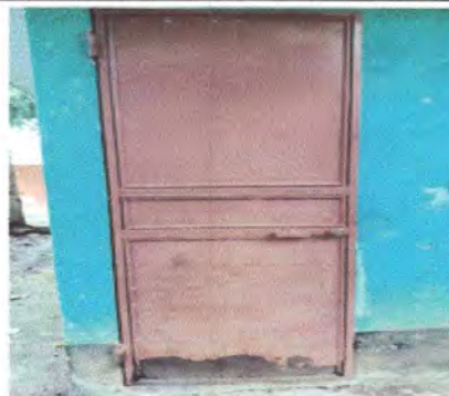
Foto 2: Sustrucción de puertas de baño
