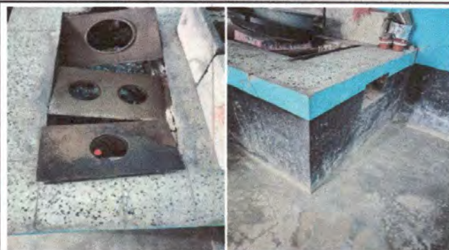
Foto 14: Sustrucción de plancha de 3 hornillas
