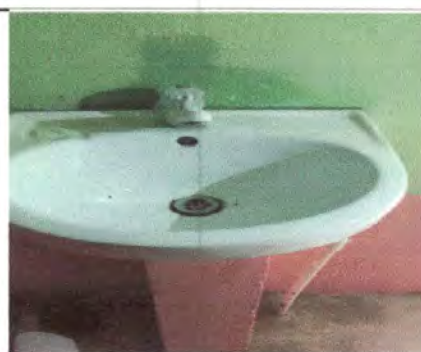
Foto 12: Sustitución de lavamanos
