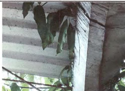
Foto 8: Sustitución de soporte o pescantes de metal para canal
