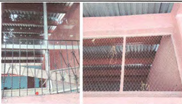
Foto 5: Sustrucción de balcones de metal
