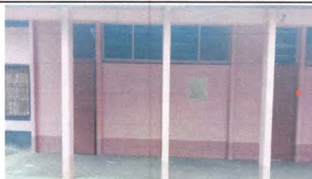
Foto 10: pintura en muros exteriores e interiores
