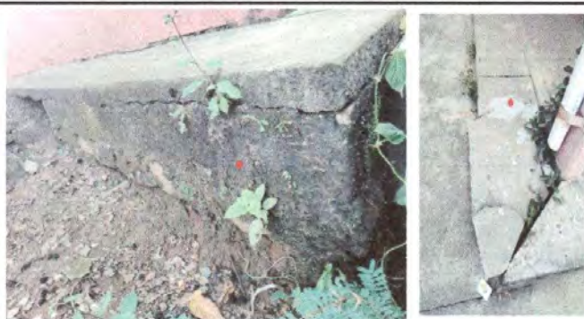
Foto 9: Reparación de banqueta de concreto
