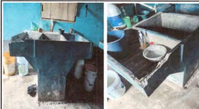
Foto 16: Sustrucción de pila de plástico de dos lavaderos
