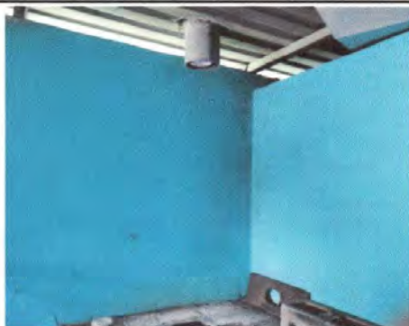
Foto 13: Sustrucción de chimenea de concreto
