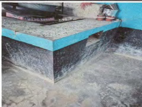
Foto 15: instalación de azulejo en plancha rural
