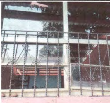
Foto 4: Sustrucción de vidrios
