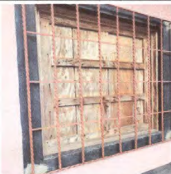
Foto 3: Sustrucción de estructura de metal de ventana
